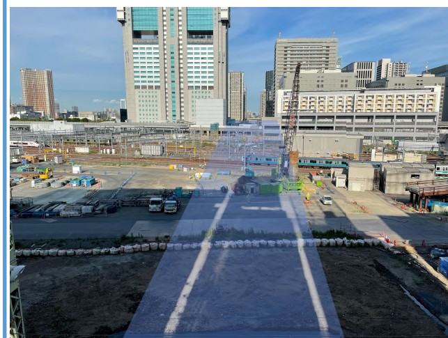
高輪方から見た鉄道横断箇所の様子（7月下旬撮影） おおむね薄青色の範囲が将来環状第4号線の橋梁がかかる部分です
